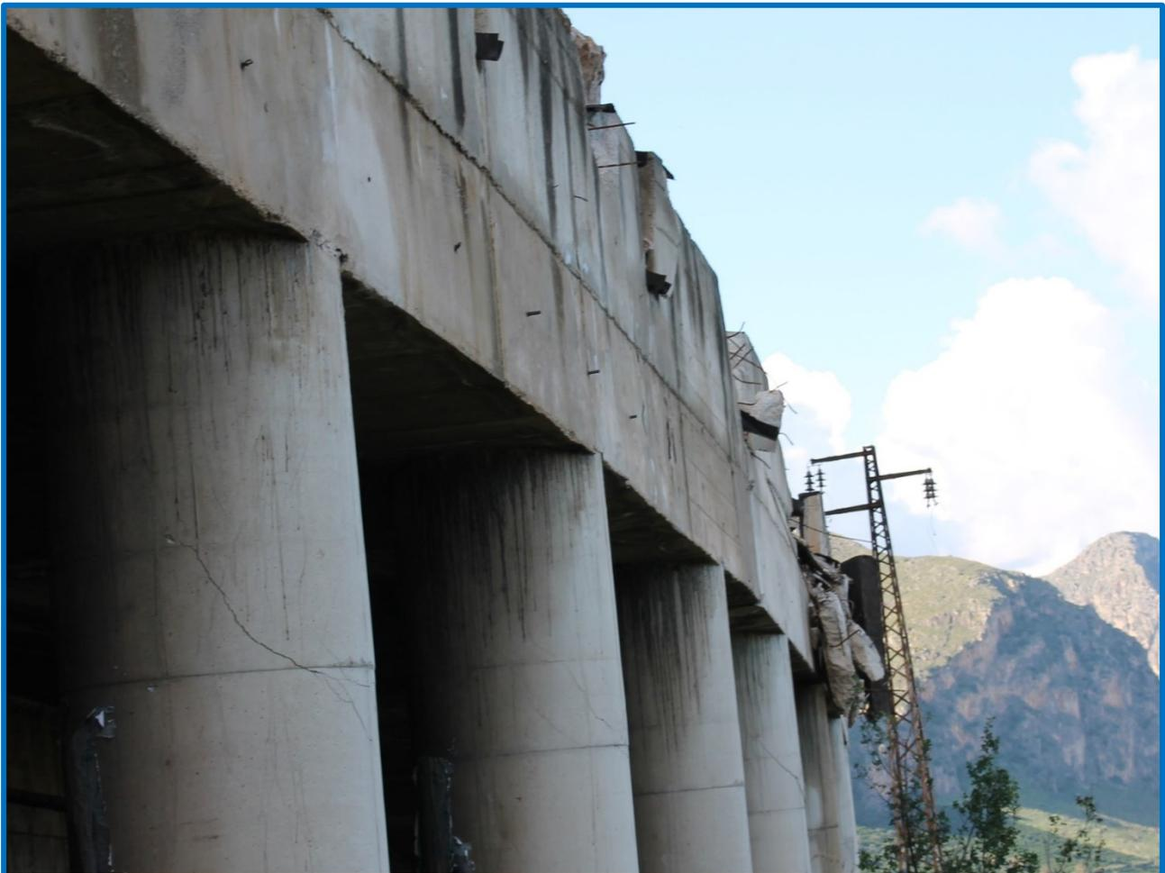
**Figg. 20, 21 - Tratti distrutti della soletta di copertura e lesioni nei pilastri di sostegno**
