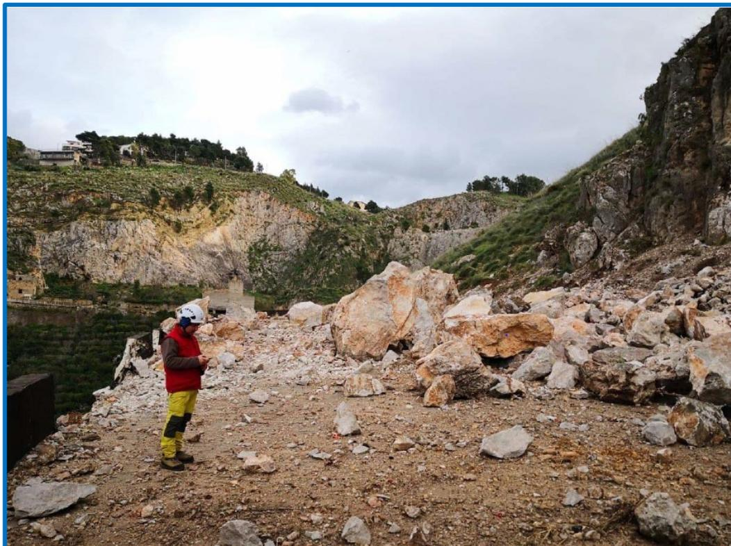
Fig. 18 - Particolare del materiale crollato depositatosi sulla galleria paramassi
