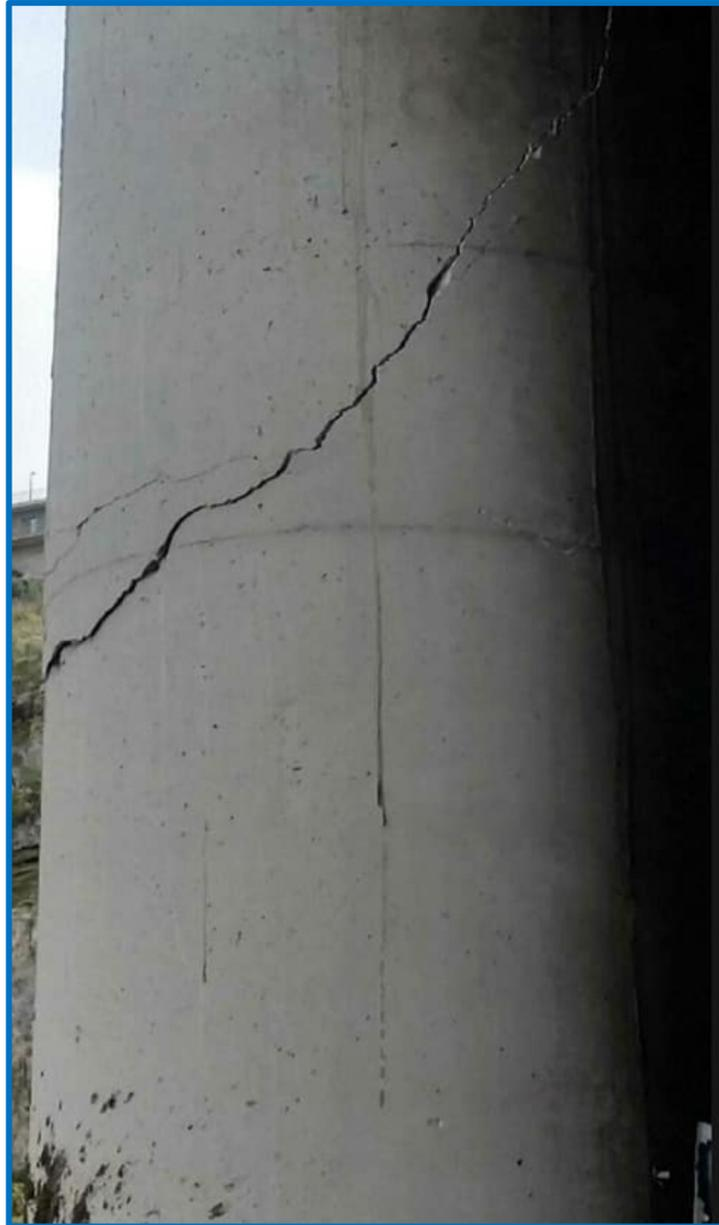
*Fig. 24 - Traslazione verso valle della parte superiore di un pilastro rispetto a quella inferiore*
