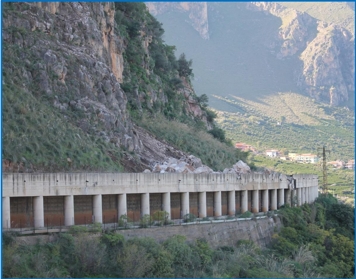
**Fig. 19 - Tratti distrutti della soletta di copertura**
